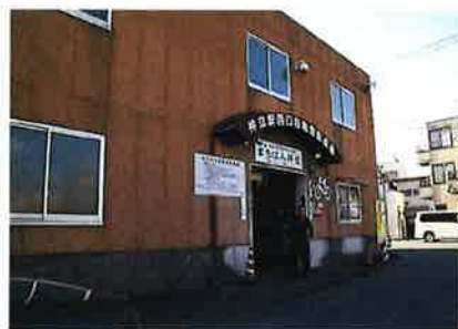
神立駅西口自転車駐車場の様子
